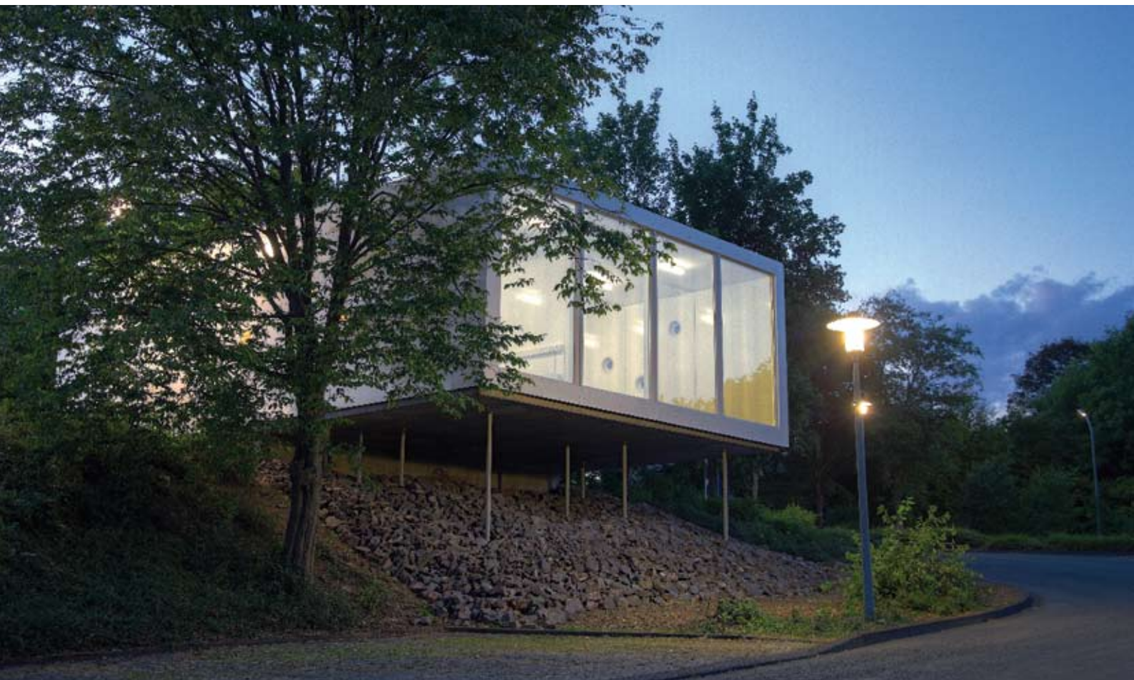
Experimentalbau Plastikuss an der Universität Siegen mit Stützen aus ULTRALITH (Durchmesser 7 cm). Fakultät II Bildung • Architektur • Künste, Department Architektur, Lehrgebiet Baukonstruktion und Entwerfen, Univ.-Prof. Sibille Wirtz, Fotograf: Alexander Kiß
