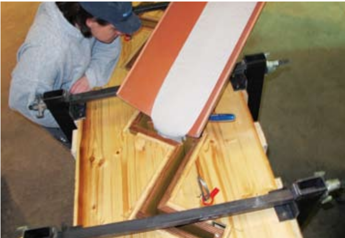
Einfüllen der UHPC-Mischung in die Schalung
