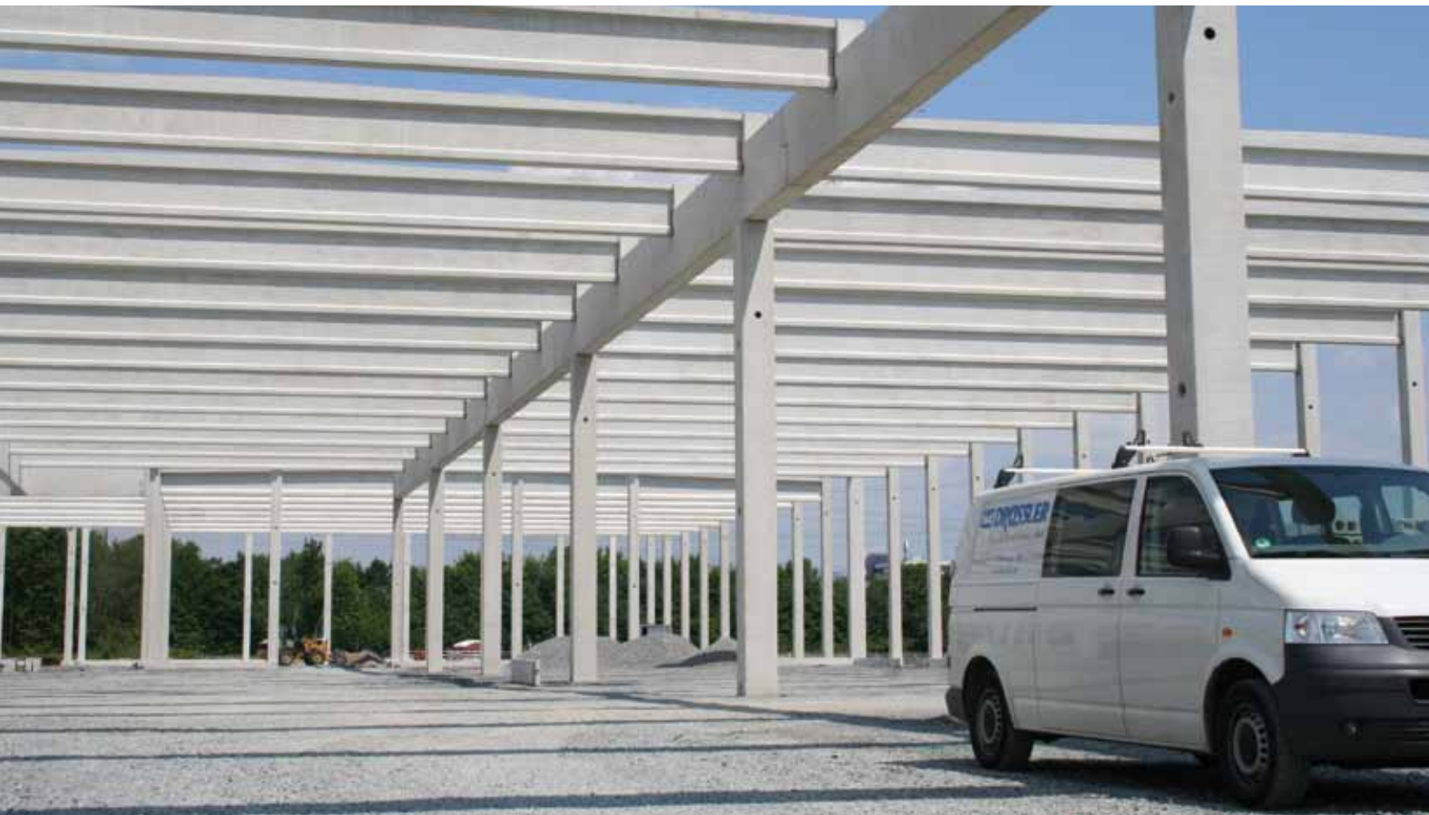
Betonfertigteilkonstruktion mit vorgespannten Bindern und Abfangeträgern
