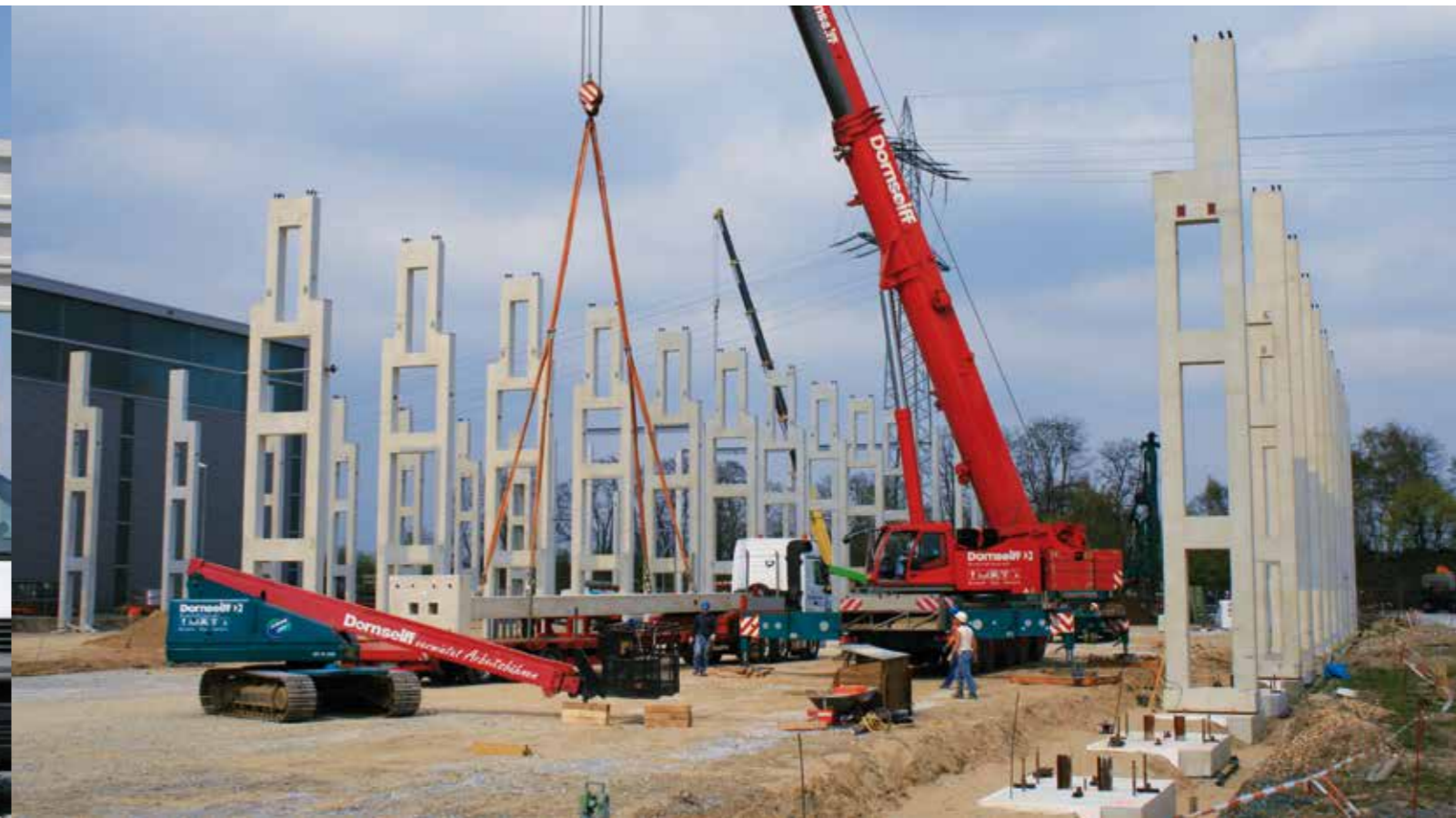
Montage af 35-tons tunge søjler med 3 mm. nøjagtighed
