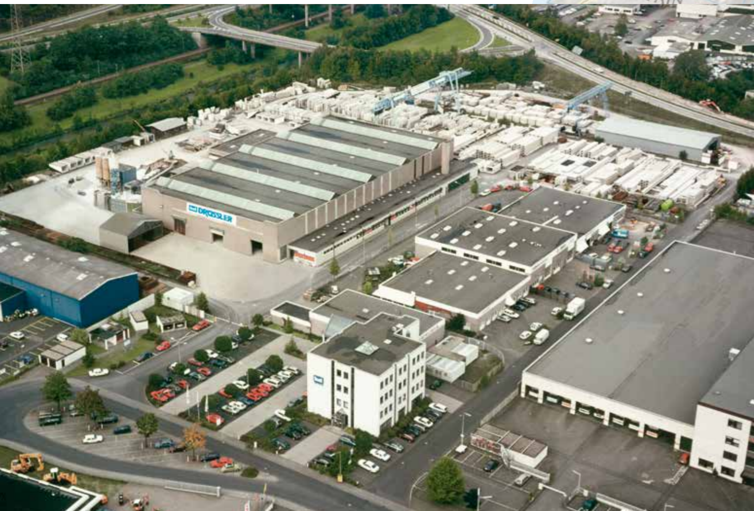
Vores fabrikk: Marienhütte, Siegen
