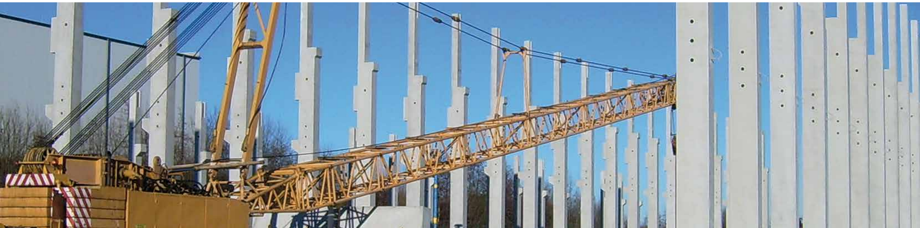
Søjlemontage af en 210 m. lang kranbanedækket hal
