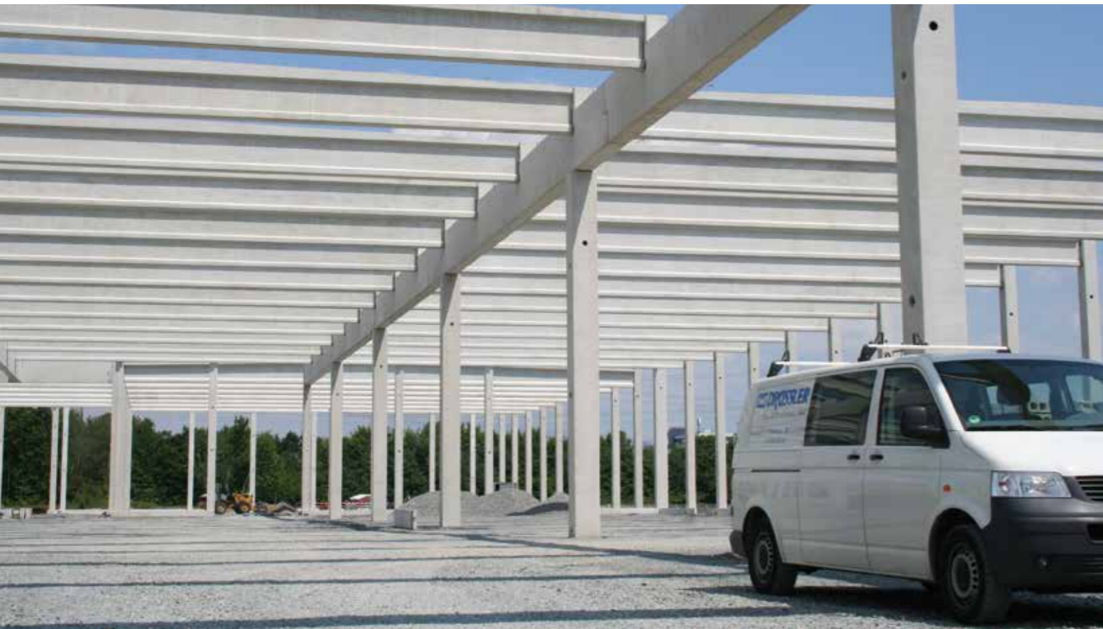
Betonkonstruktion med forspændte spær og bjælker
