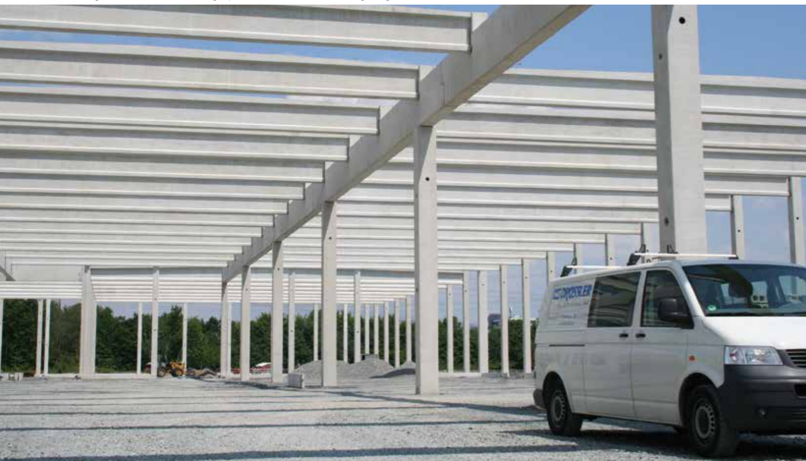
Betonfertigteilkonstruktion mit vorgespannten Bindern und Abfangeträgern
