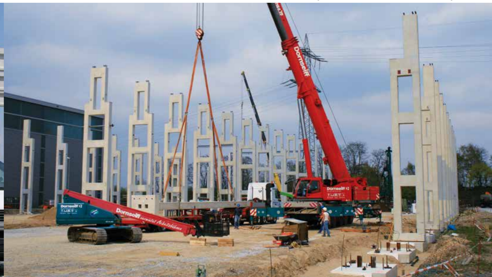
Montage von 35 t schweren Stützen mit 3 mm Genauigkeit
