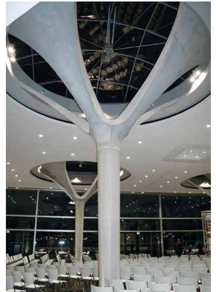
Dreidimensional geformte Sonderarchitektur-Elemente Mitarbeiter-Restaurant Boehringer Ingelheim
