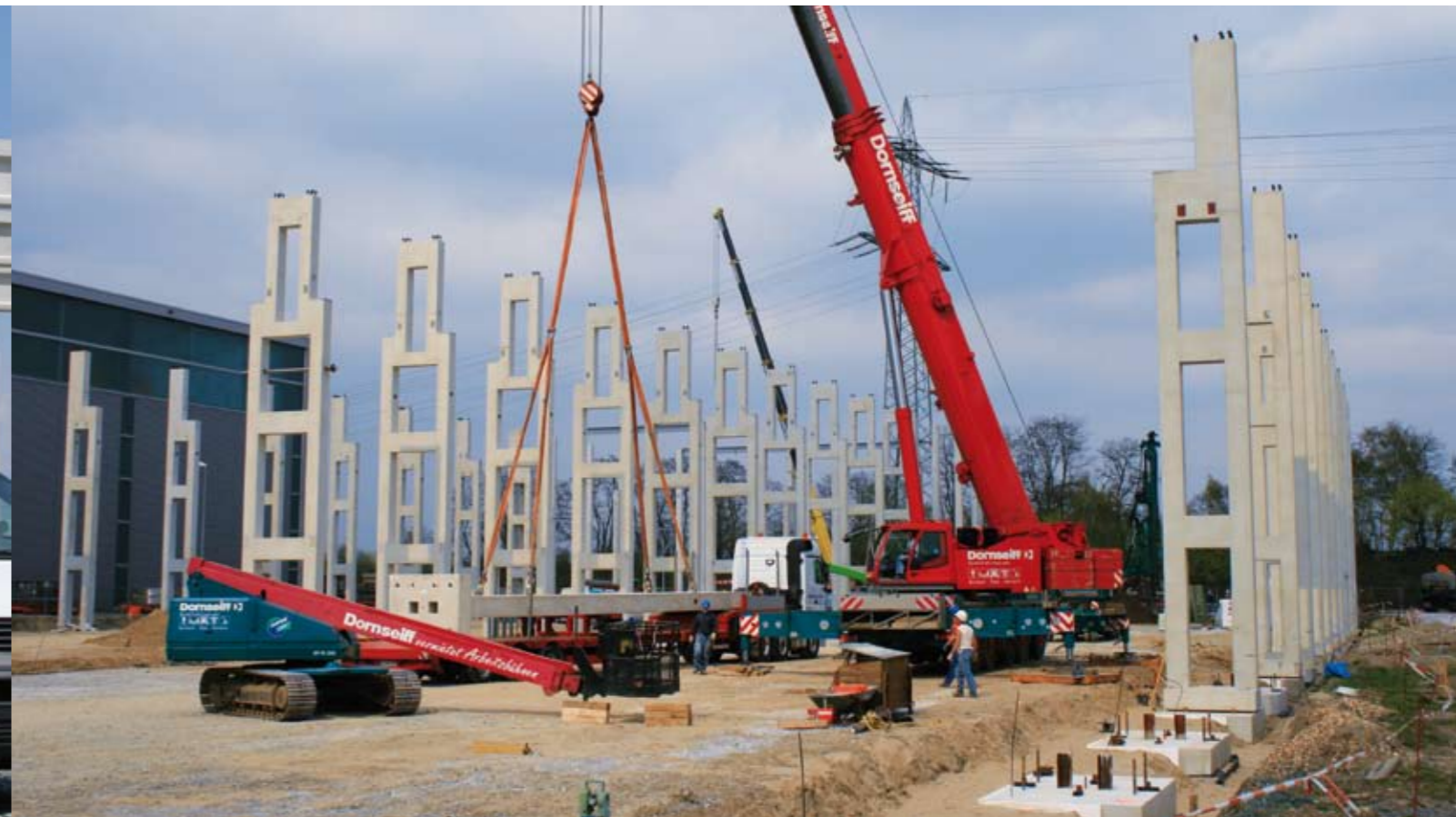
Montage von 35 t schweren Stützen mit 3 mm Genauigkeit
