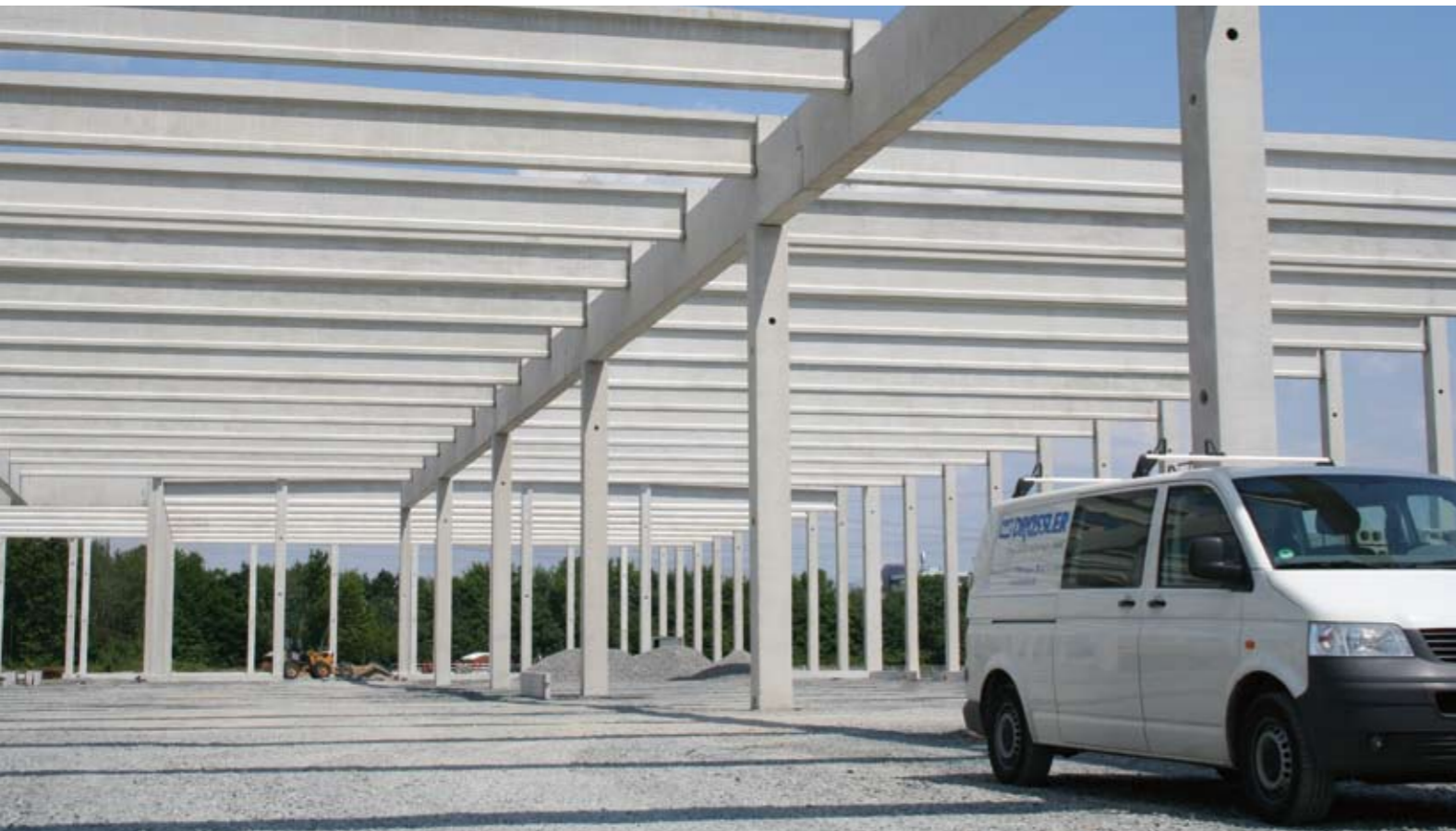
Betonfertigteilkonstruktion mit vorgespannten Bindern und Abfangeträgern
